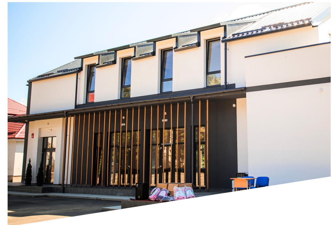
Új épületszárny a Rákóczi iskolában
