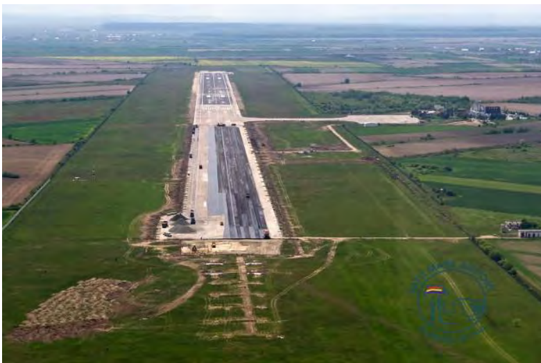
Figură 2-52 Pista de aterizare/decolare în timpul lucrărilor de reabilitare. Sursa: http://www.aeroportulsatumare.ro/
