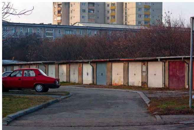
Figură 2-37 Baterii de garaje în municipiul Satu Mare pe Aleea Timișului, Sursa: Consultantul
