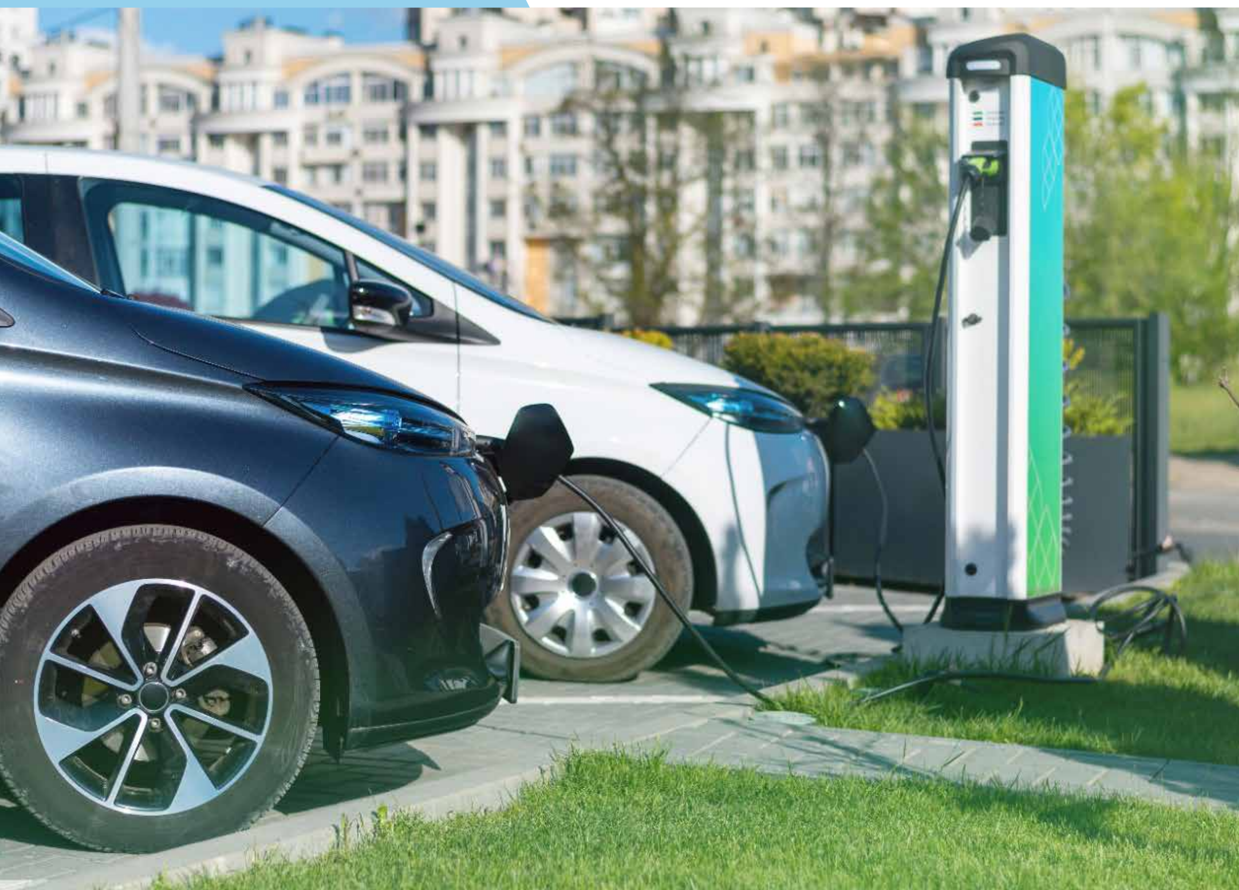
⦿ Elektromos töltőállomások létesítése
