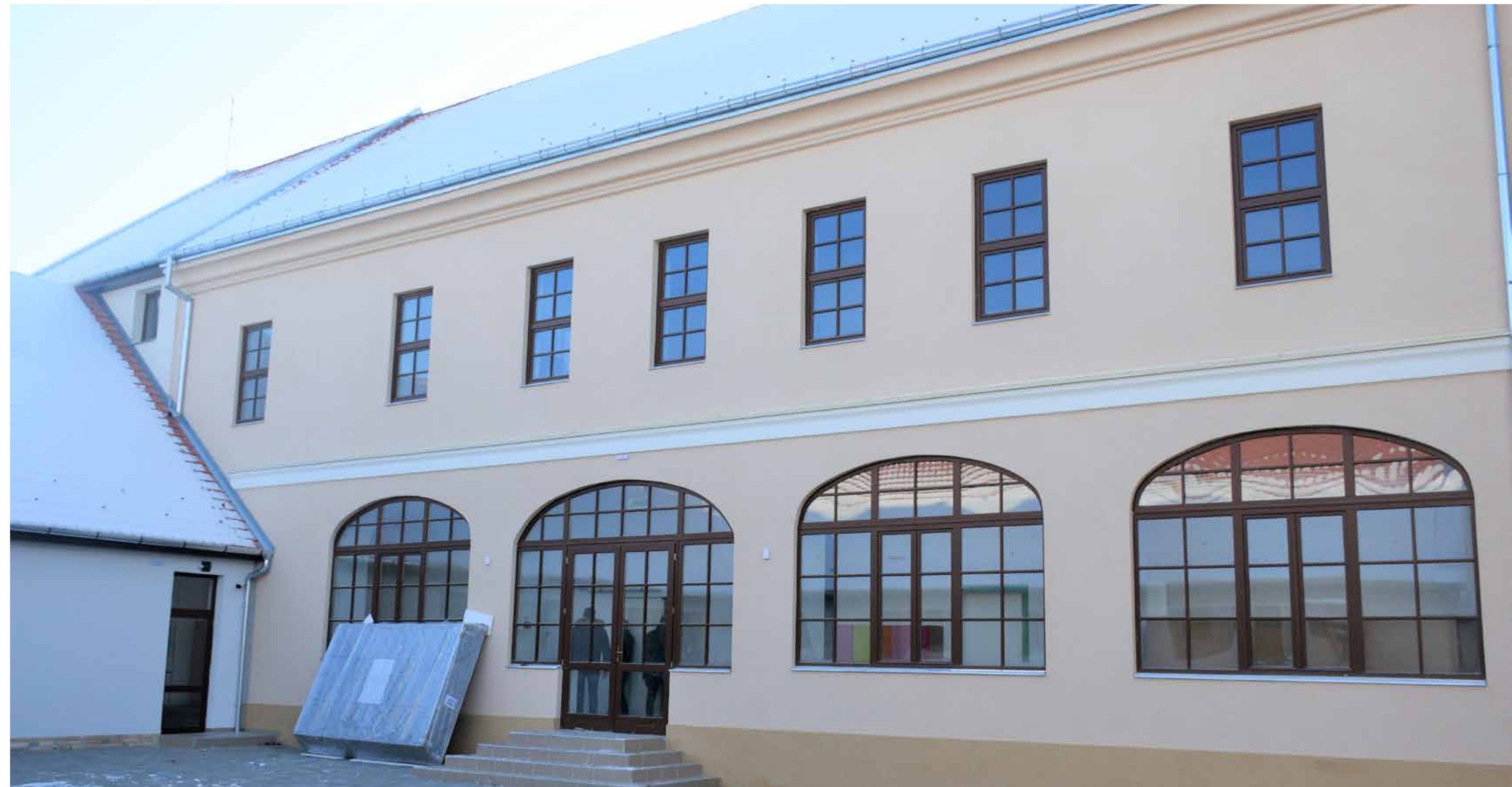
🕒 Reabilitare infrastructură educațională Grădinița nr. 7 valoare 3.896.832 lei, stadiu 90%
