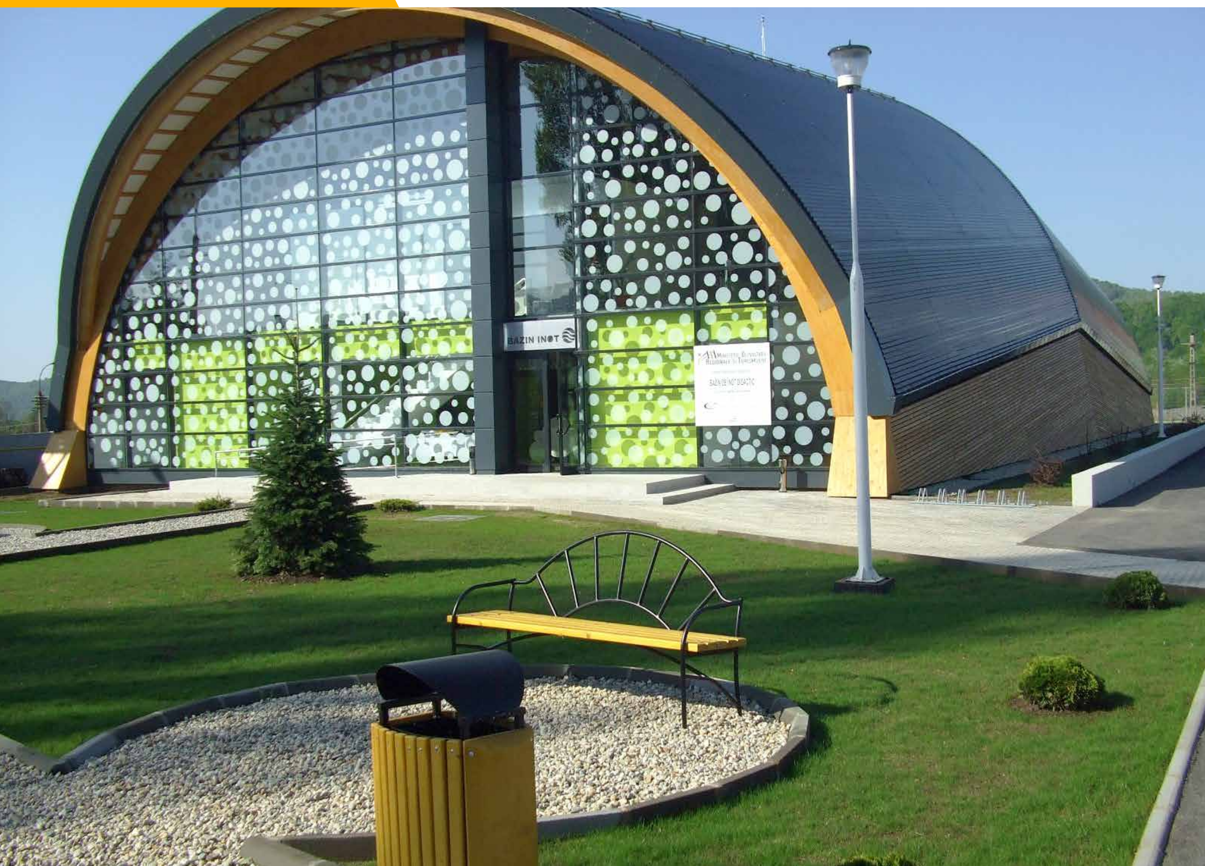
📍 Construirea bazinului de înot didactic pe str. Crișan
